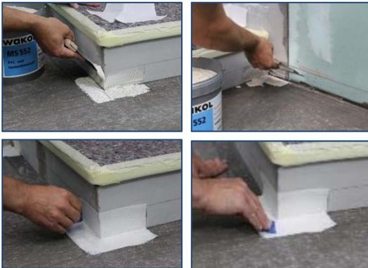
**\*Paso 2 //** Aplicar adhesivo para PVC y caucho WAKOL MS 552 PVC con el dentado TKB B1 en la zona de las esquinas interiores y exteriores.
