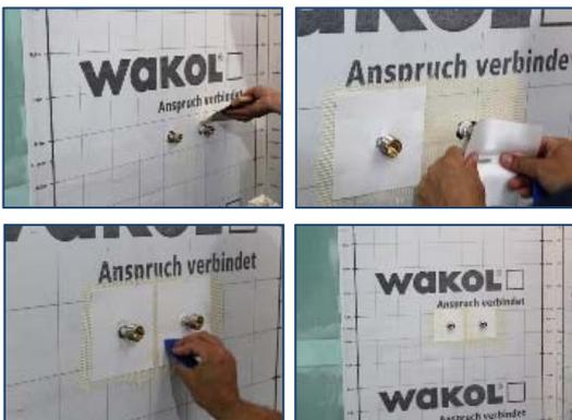
**\*Paso 8 //** Aplicar el adhesivo para PVC y caucho WAKOL MS 552 en la zona de las aberturas de instalación en la pared y dejar ventilar al menos 20 minutos.
