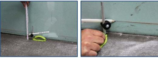
**\*Paso 1 //** Marcar la zona de la cobertura de la pared para la aplicación del adhesivo en la pared y el suelo a una altura y anchura de 6 cm.
