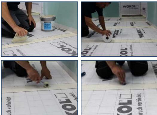
**\*Paso 7 //** Aplicar el adhesivo para PVC y caucho WAKOL MS 552 en la zona marcada a la izquierda y la derecha de la junta del rollo y dejar ventilar al menos 20 minutos.
