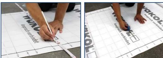
**\*Paso 4 //** Dibujar y cortar el rollo estanqueizante WAKOL AS 151 en la zona del suelo y la pared.
